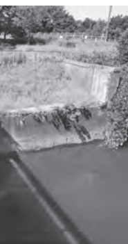
写真2 掛樋北翼壁(右上)と橋台翼壁(下)
