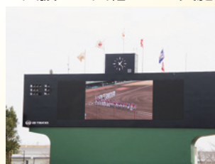
改修後のスコアボード
