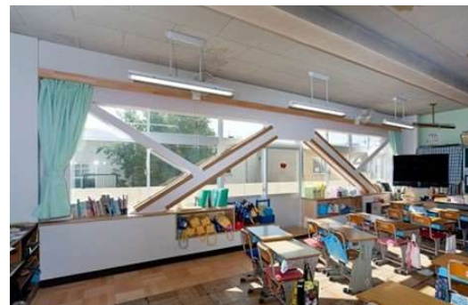
耐震補強後の教室の様子
