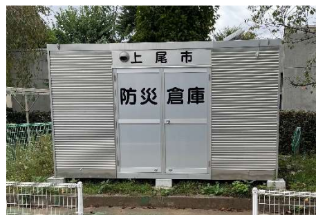
学校敷地内の防災倉庫
