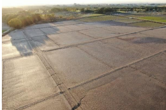
堆積した土砂等（11月15日撮影）
