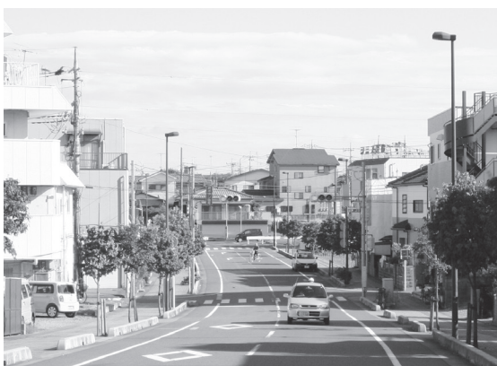
西宮下中妻線の供用開始部分
