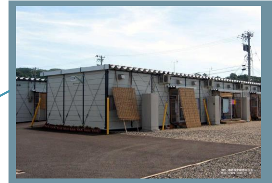
災害時には応急仮設住宅の建設も可能
