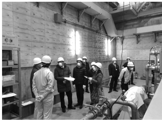
発電機を現地調査
