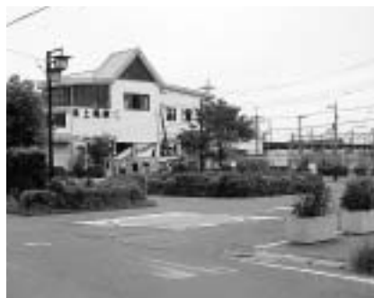
西口広場の整備が望まれる北上尾駅
