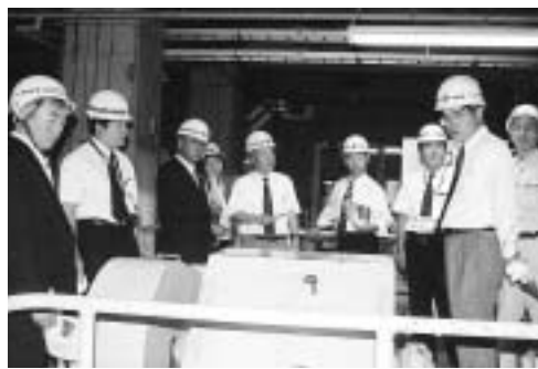
芝川ポンプ場を現地調査する建設水道常任委員会
