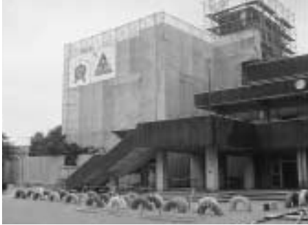
大規模改造工事を実施する芝川小学校
