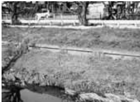
土のうが積まれている鴨川左岸
