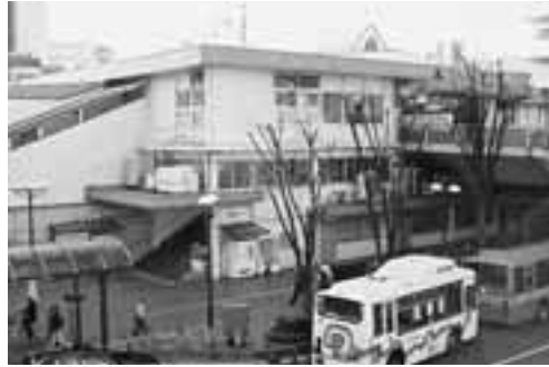
改修予定の上尾駅
