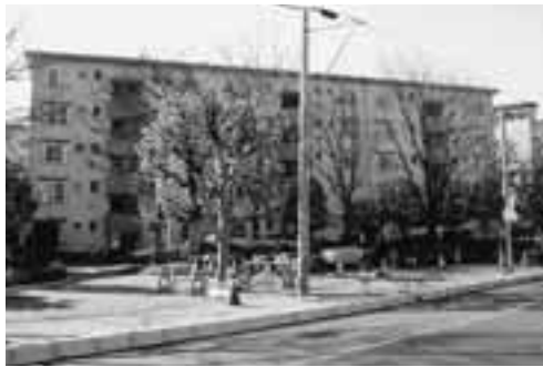
西上尾第一団地前の歩道整備
