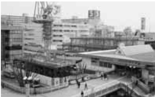
改修工事が進む上尾駅
