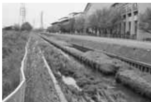
しゅんせつ工事が予定されている芝川
