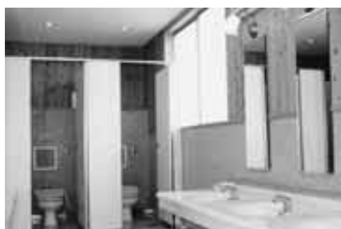
改修された芝川小学校のトイレ
