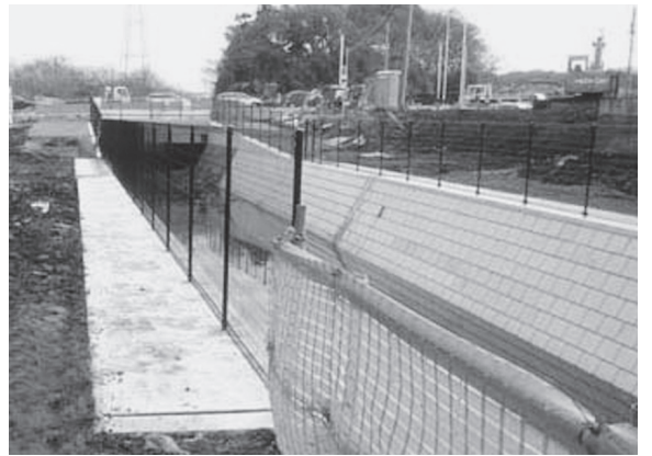
浅間川改修工事の様子
