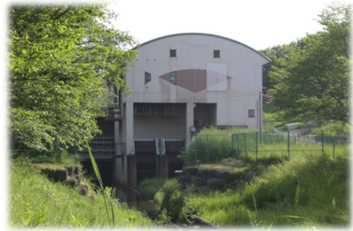
丸山ポンプ場
